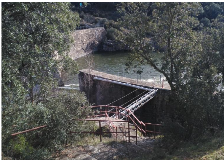
Figura 1.- Paso de la tubería sobre el canal de descarga
